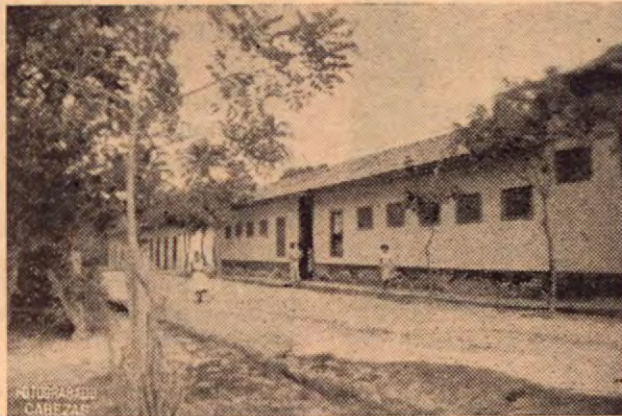
Hospital actual de Liberia en mal estado
